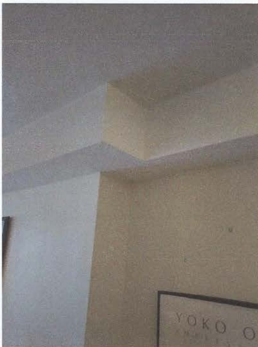
Bilde 2: Rør for balansert ventilasjon er kasset inn. Bildet er hentet fra et pågående prosjekt hvor det etableres balansert ventilasjon.
