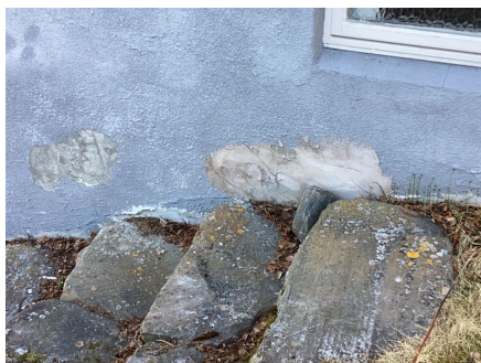
Reparasjon av murpuss.
