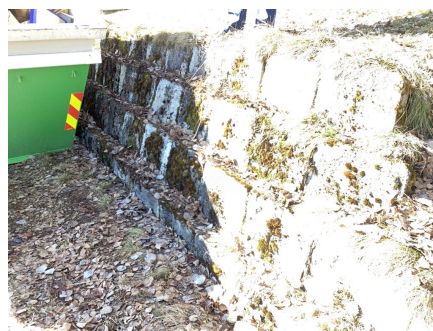
Støttemur av murblokker.
