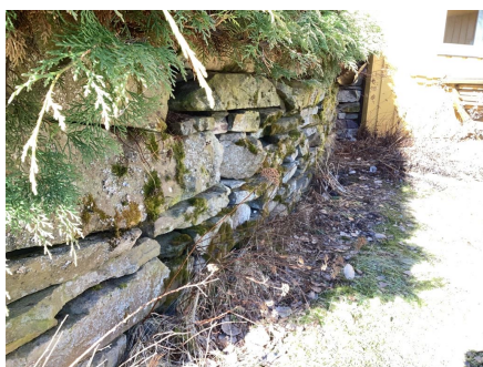
Støttemur av naturstein.
