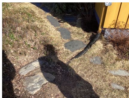
Eksempel på takvann som ledes ned i bakken.
