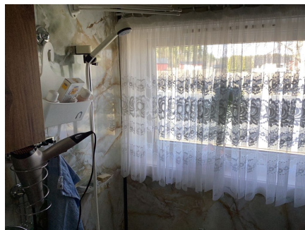
Vindu i våtsone på vegg.
