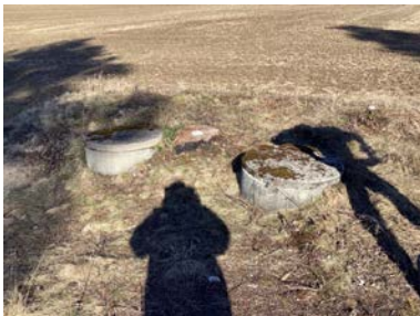
Brønn og kum med pumpe og trykktank.
