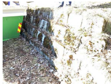
Støttemur av murblokker.
