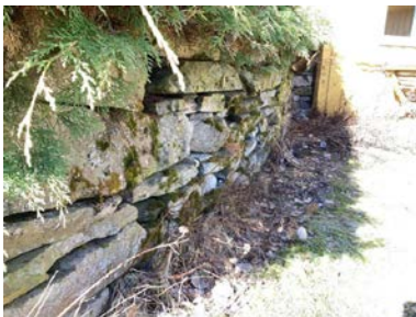
Støttemur av naturstein.
