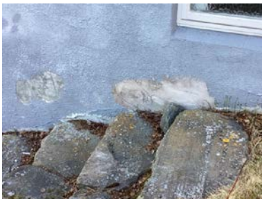
Reparasjon av murpuss.
