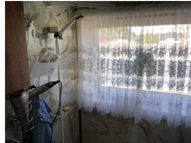
Vindu i våtsone på vegg.
