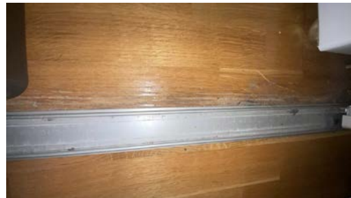
Vindfang ved skyvedør
