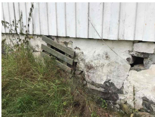
Del av grunnmur.
