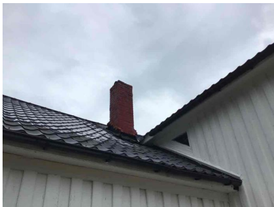
Pipe mot nordvest.
