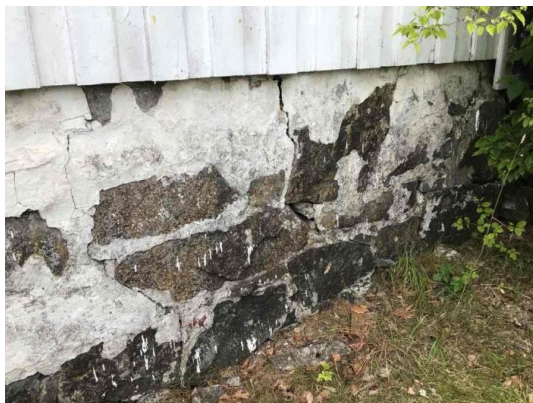
Del av grunnmur.
