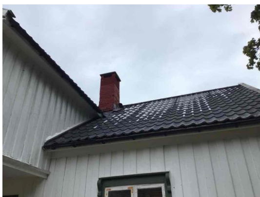
Pipe mot sørøst.
