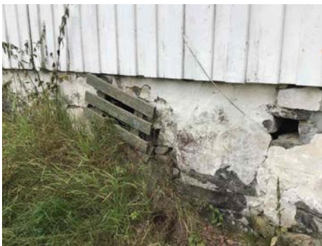
Del av grunnmur.
