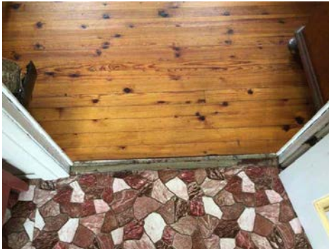
Del av overflate gulv.
