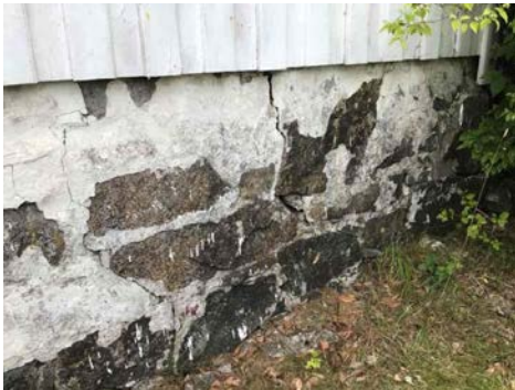
Del av grunnmur.
