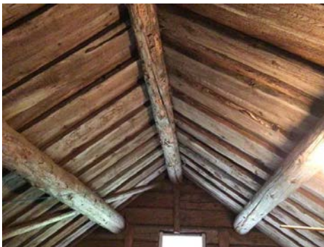
Utsnitt takkonstruksjon.
