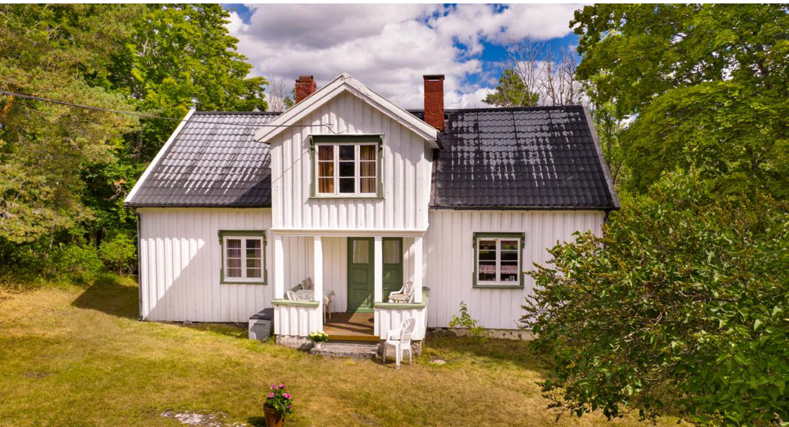
Hovedhuset har overbygd inngangsparti som fører inn til gang med trapp til 2. etasje.
