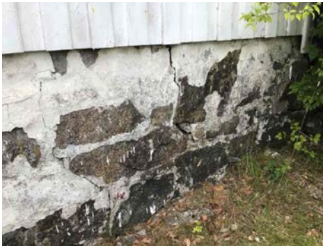
Del av grunnmur.
