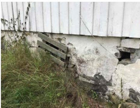
Del av grunnmur.
