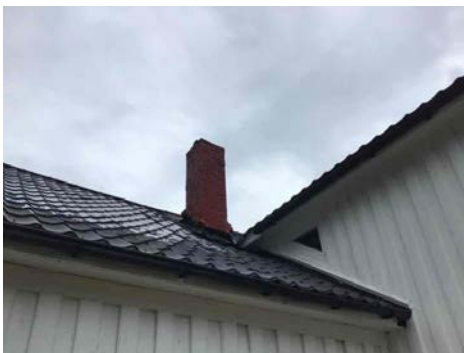
Pipe mot nordvest.
