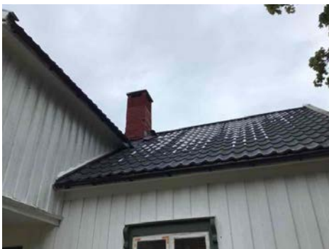
Pipe mot sørøst.
