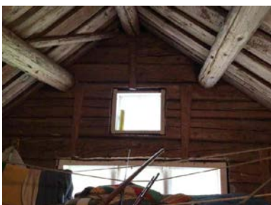
Del av tømmerkonstruksjon.
