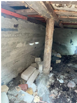
Noe provisorisk understøttelse av bjelkelag.
