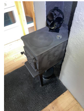
Sotluke bak vedovn på kjøkken,.
