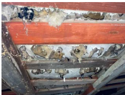
Synlig skader etter mus i stubbeloft
