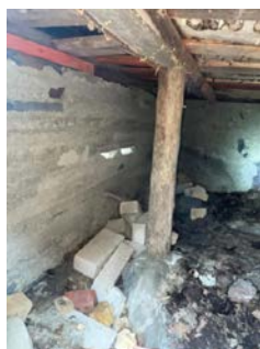
Noe provisorisk understøttelse av bjelkelag.
