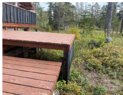
Manglende rekkverk
