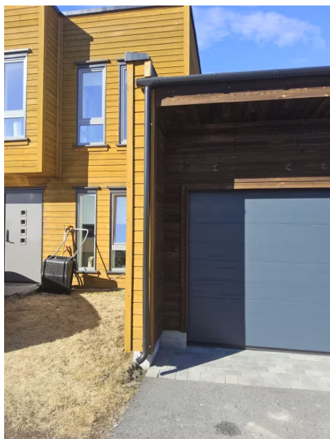
Takrenne og nedløp i metall tilknyttet tak over carport og sportsbod.
