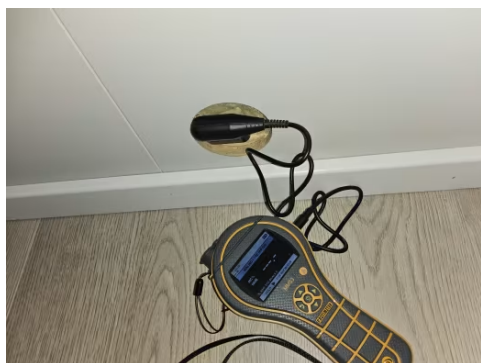
Bilde fra fuktmåling i veggkonstruksjon tilstøtende våtsone.
