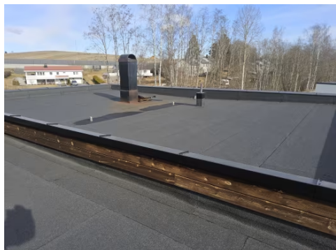
Yttertaket er tekket med asfaltpapp.
