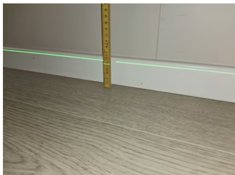
Etasjeskille ble kontrollert med nivelleringslaser.
