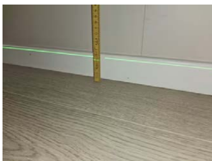
Etasjeskille ble kontrollert med nivelleringslaser.
