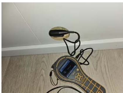
Bilde fra fuktmåling i veggkonstruksjon tilstøtende våtsone.
