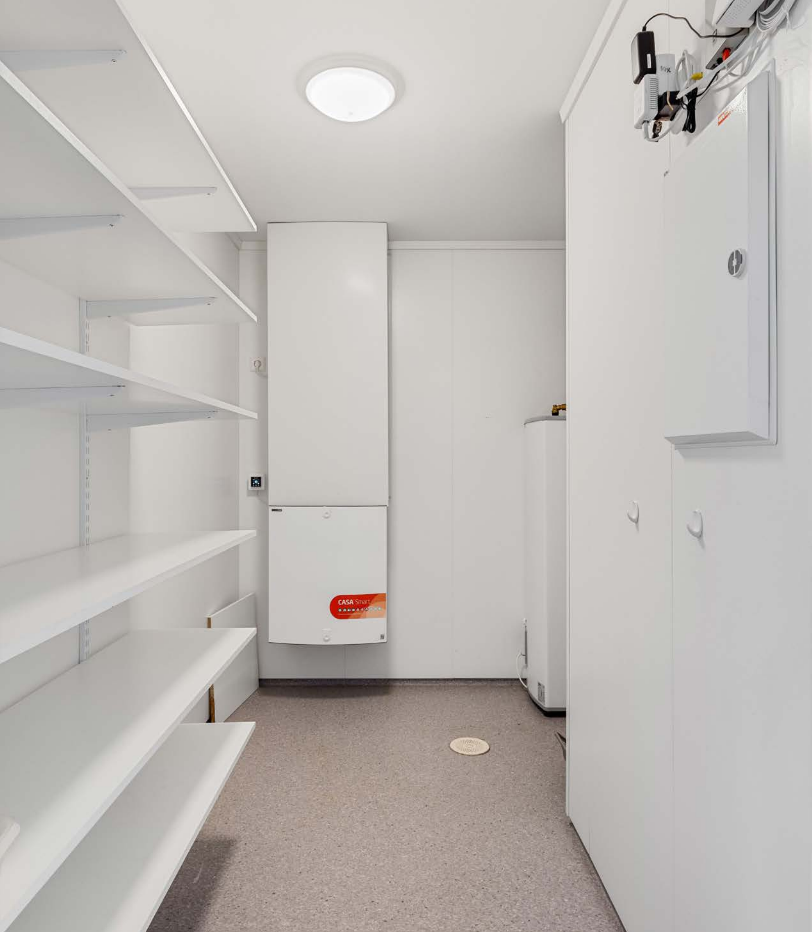
Praktisk innvendig bod/teknisk rom med gode lagringsmuligheter.
