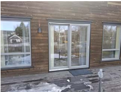
Vinduer og balkongdør er utvendig kledd med beslag av metall.
