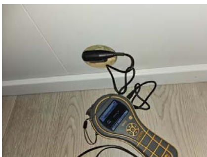
Bilde fra fuktmåling i veggkonstruksjon tilstøtende våtsone.
