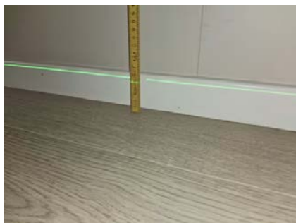
Etasjeskille ble kontrollert med nivelleringslaser.
