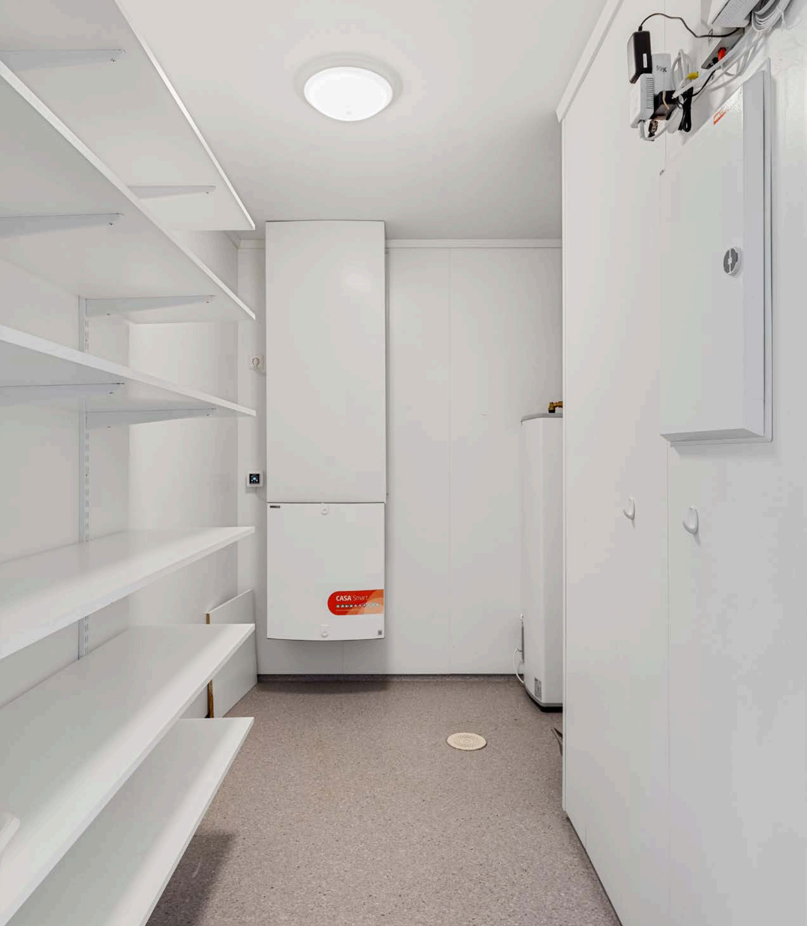
Praktisk innvendig bod/teknisk rom med gode lagringsmuligheter.
