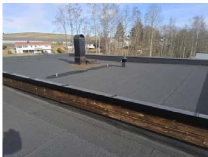
Yttertaket er tekket med asfaltpapp.
