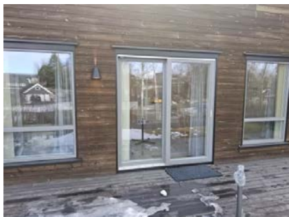
Vinduer og balkongdør er utvendig kledd med beslag av metall.
