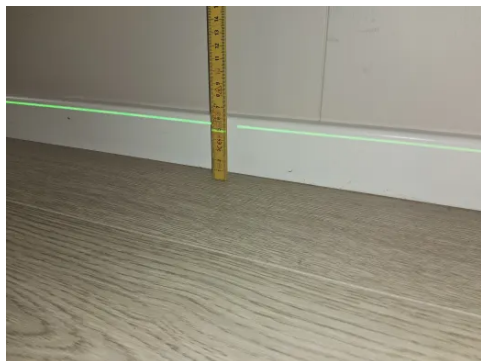
Bilde viser måling av etasjeskiller.
