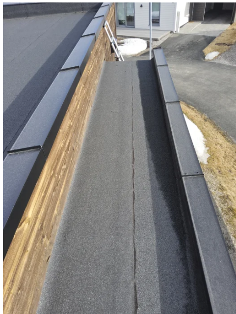
Bilde viser taktekking.
