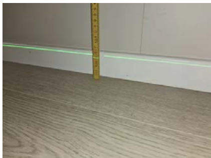
Bilde viser måling av etasjeskiller.
