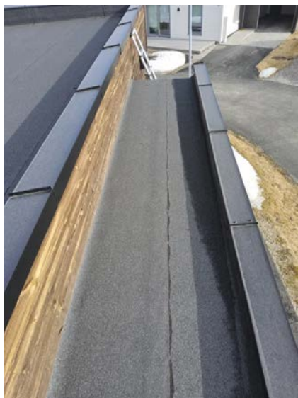
Bilde viser taktekkning.
