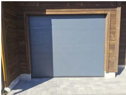
Boligen har integrert garasje med isolert leddport.
