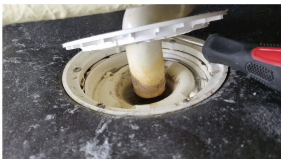
Kontroll av sluk.
