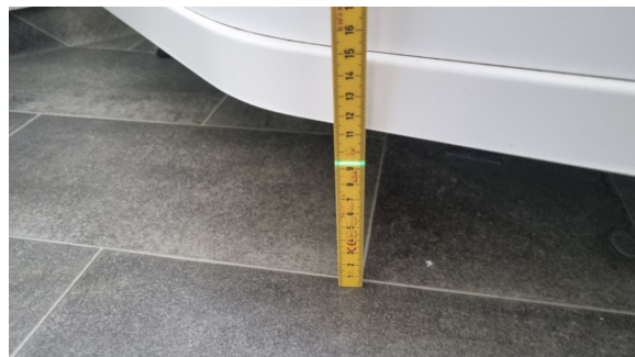
Gulvet har fall til sluk.
