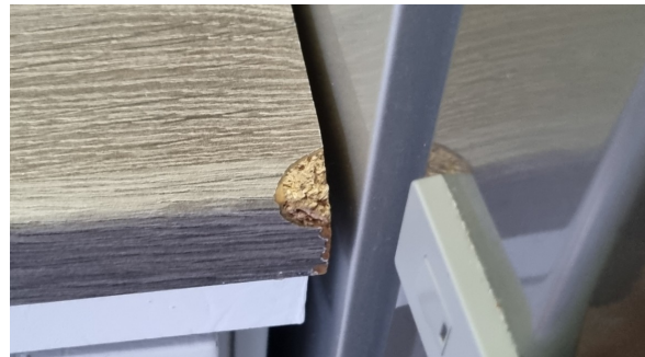
Skade i benkeplate
