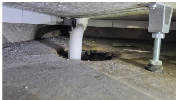
Kontroll av sluk.
