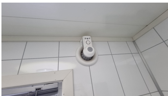
Mekanisk avtrekksvifte.
