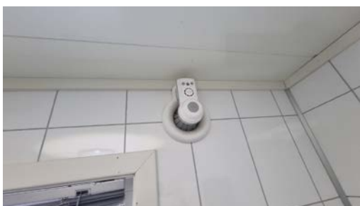
Mekanisk avtrekksvifte.
