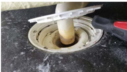
Kontroll av sluk.
