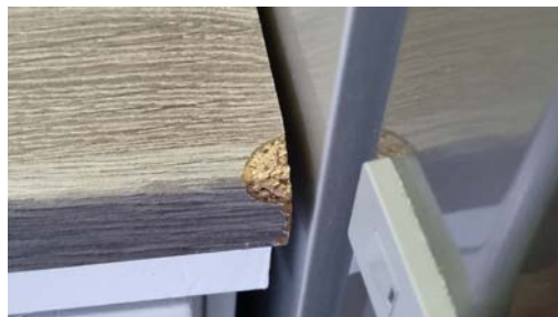
Skade i benkeplate
