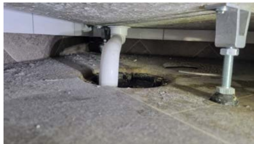
Kontroll av sluk.
