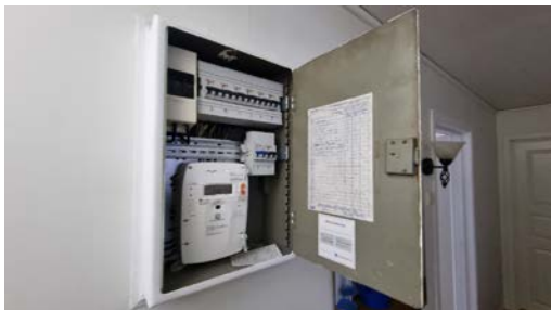
Kontroll av el-skap og kursfortegnelse 1. etasje
