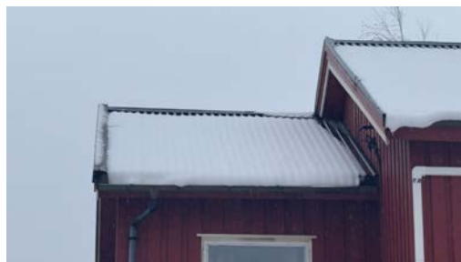
Taktekking er snødekt.
