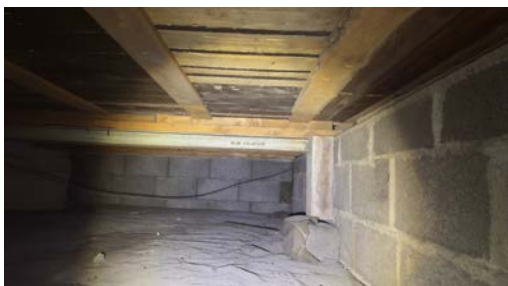
Ingen inspeksjonsmulighet utover gjennom ventilhull i grunnmur.
