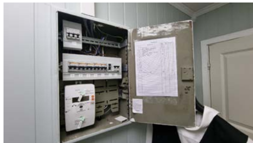
Kontroll av el-skap og kursfortegnelse 2. etasje
