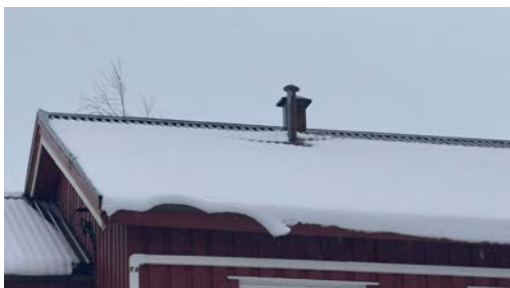
Taktekking er snødekt.
