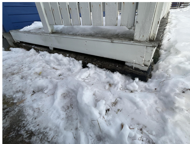
Terrasse fundamentert på sviller anlagt på terreng
