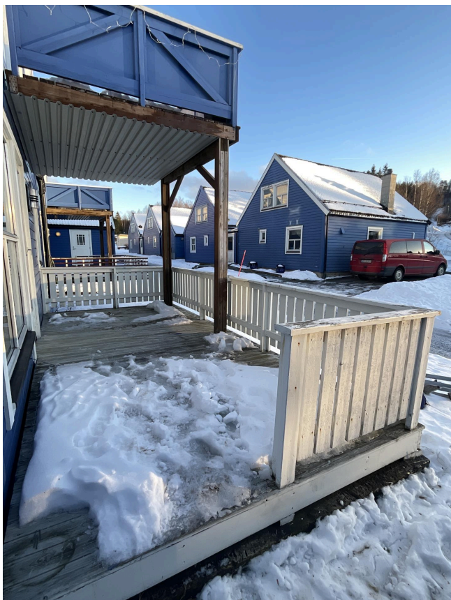
Terrasse fundamentert på sviller anlagt på terreng
