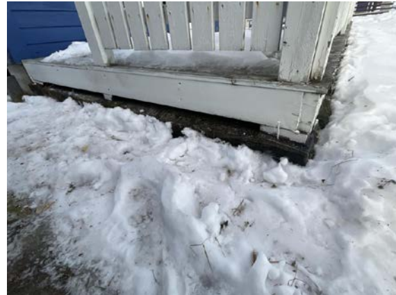
Terrasse fundamentert på sviller anlagt på terreng
