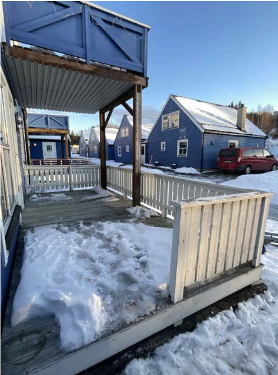
Terrasse fundamentert på sviller anlagt på terreng
