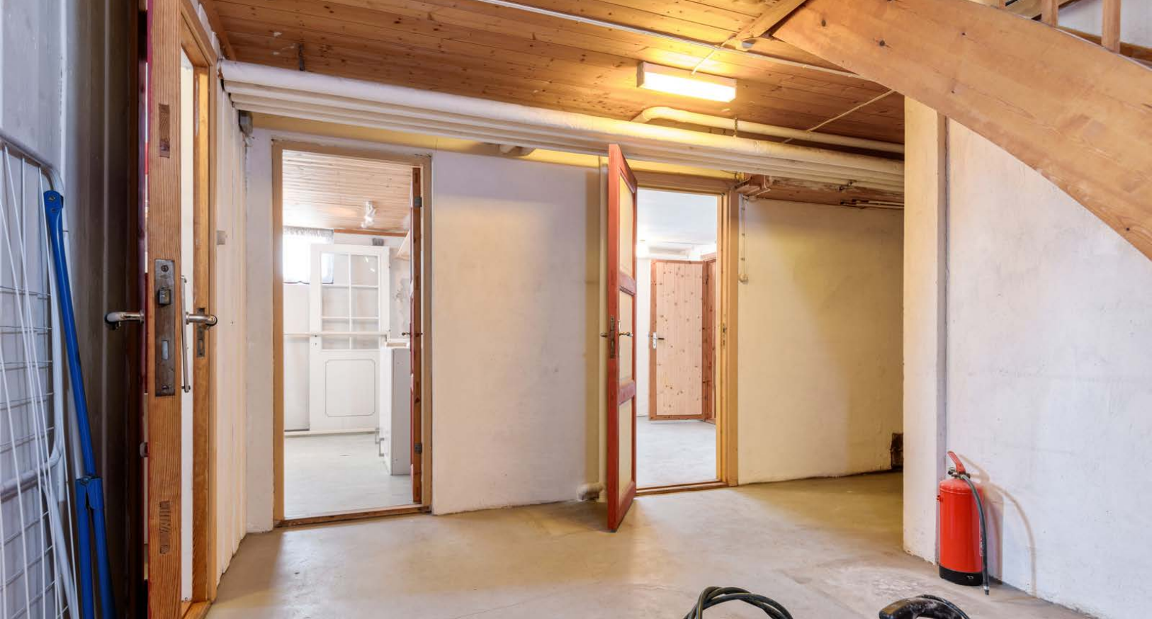
Kjelleren inneholder i dag gang, toalettrom (ikke i bruk), bad/vaskerom, badstue, fyrrom/teknisk rom, to boder og to kjellerrom.
