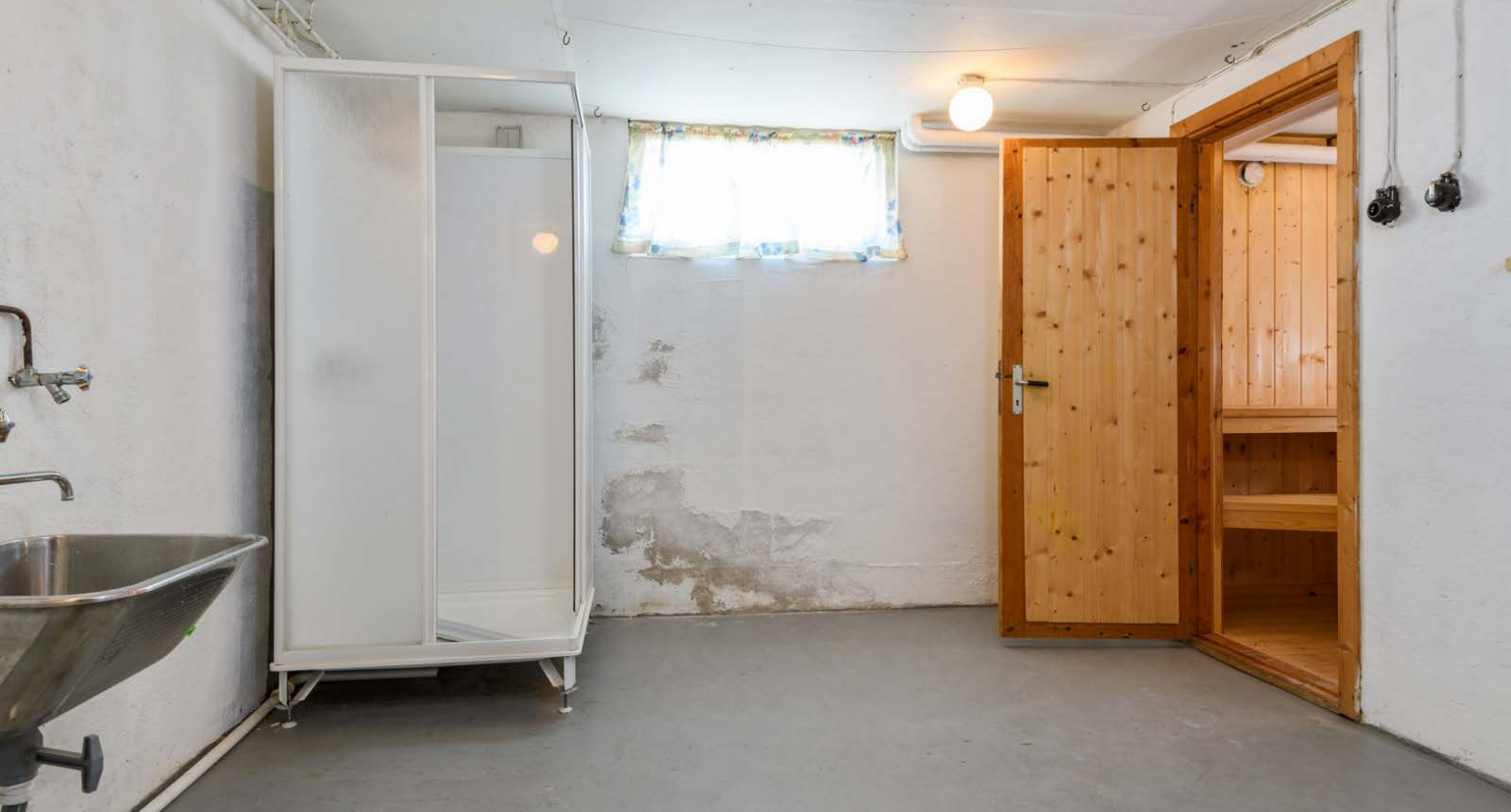
Bad/vaskerom i kjeller med støpt gulv og overflater med malt murpuss, antatt fra byggeåret. Rommet er utstyrt med dusjkabinett, utslagskum og sluk.
