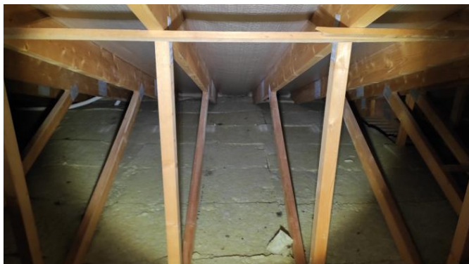
Fuktmåling i takkonstruksjon.
