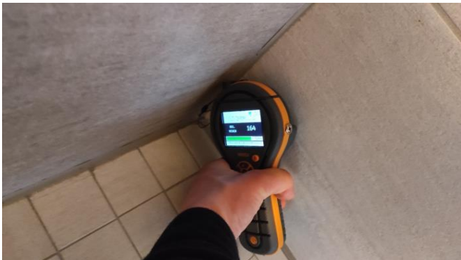
Fuktmåling i dusjsone.
