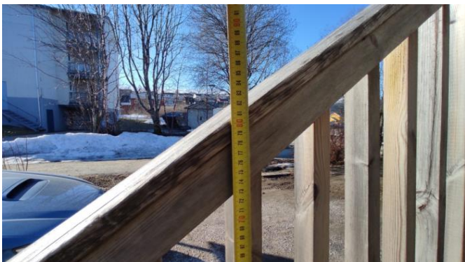
Kontroll av rekkvehøyde.
