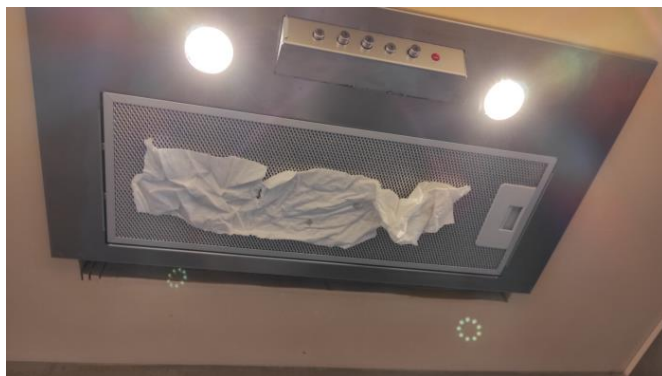
Funksjonstest av ventilator.
