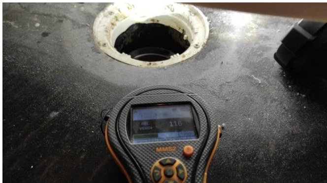
Fuktsøk rundt sluk.
