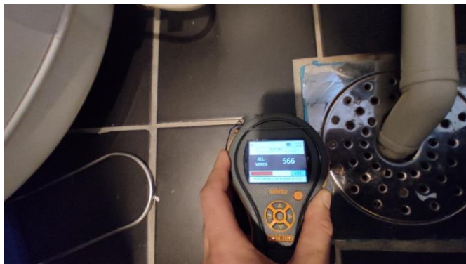
Fuktsøk rundt sluk.
