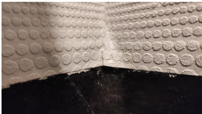
Våtromstapet slipper i bunn og har rift.
