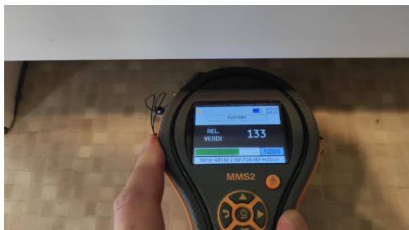
Fuktsøk rundt sluk.
