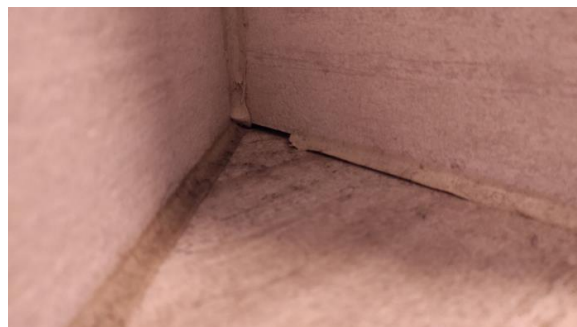
Drensåpning fra den innebygde sisternen.
