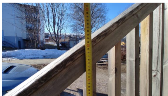
Kontroll av rekkvekshøyde.
