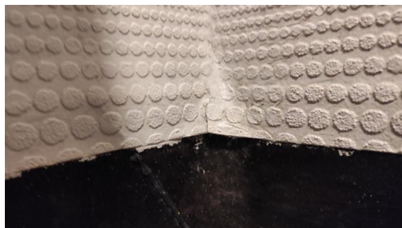
Våtromstapet slipper i bunn og har rift.
