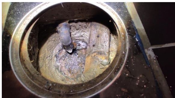
Eldre slukløsning.
