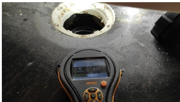
Fuktsøk rundt sluk.
