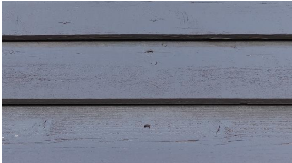
Ufagmessig innfestning av kledning.
