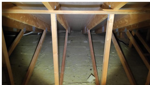
Fuktmåling i takkonstruksjon.
