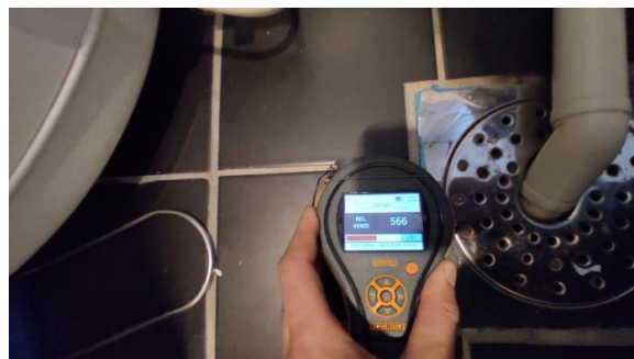
Fuktsøk rundt sluk.
