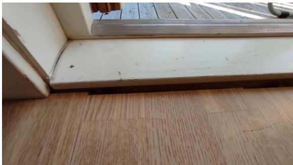
Ufagmessig avslutning av gulv.
