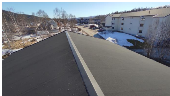
Kontroll av taktekket.
