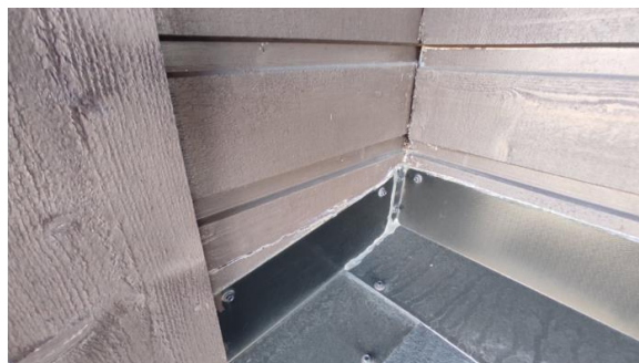
Tak/vegg beslag er montert utenpå kledningen.
