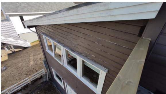
Ufagmessig innfestning av kledning.
