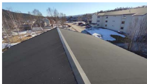
Kontroll av taktekket.
