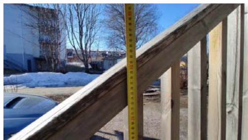
Kontroll av rekkeverkshøyde.
