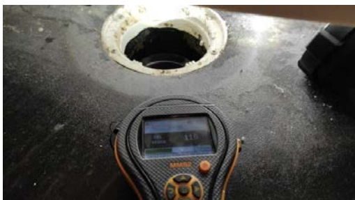
Fuktsøk rundt sluk.
