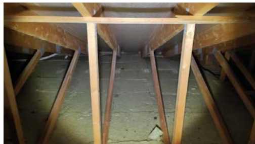
Fuktmåling i takkonstruksjon.
