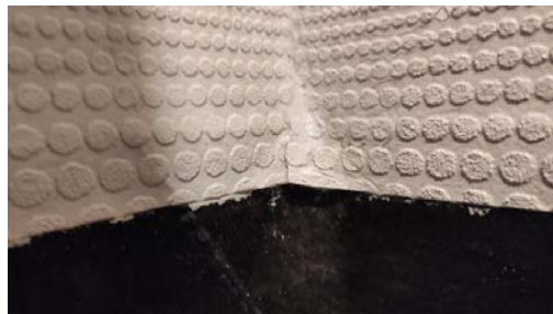
Våtromstapet slipper i bunn og har rift.
