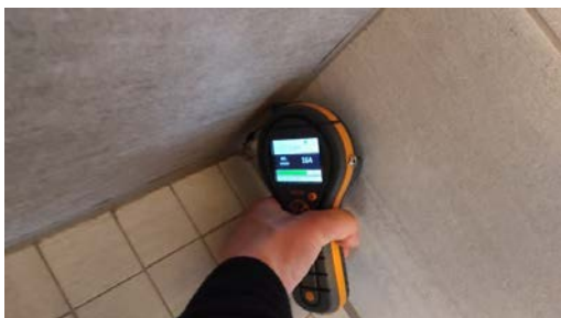
Fuktmåling i dusjsone.
