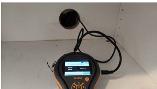
Fuktmåling i vegg.
