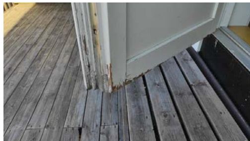
Fuktsvell i nedre del av dørblad.
