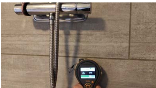
Fuktmåling i vegg.
