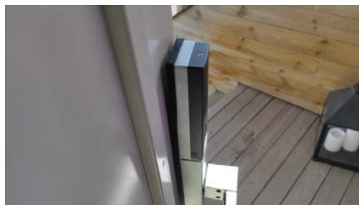
Fuktsvell i nedre del av dørblad.
