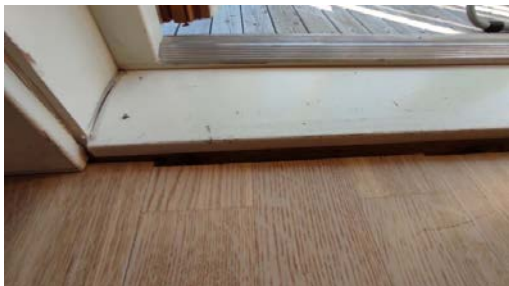
Ufagmessig avslutning av gulv.
