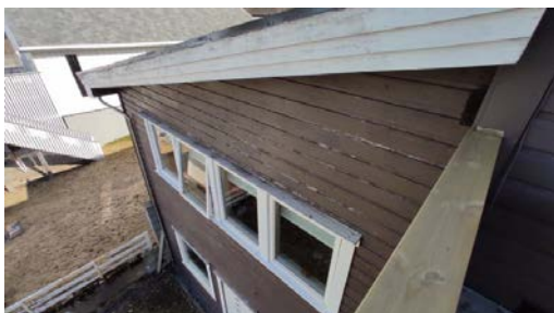
Ufagmessig innfestning av kledning.
