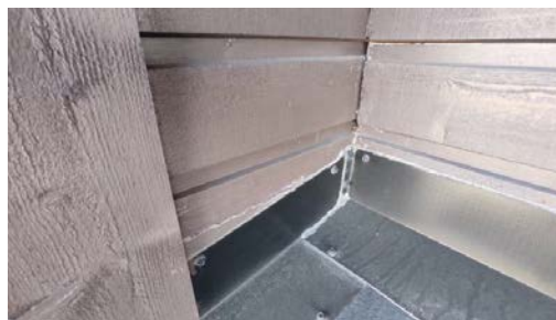
Tak/vegg beslag er montert utenpå kledningen.
