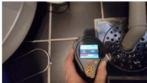
Fuktsøk rundt sluk.
