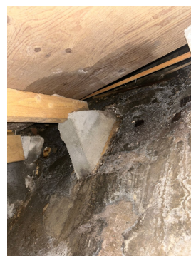
Bildet av underside bod, som vender mot krypkjeller.
