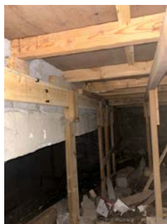
Bildet er av underside bod, som vender mot krypkjeller.
