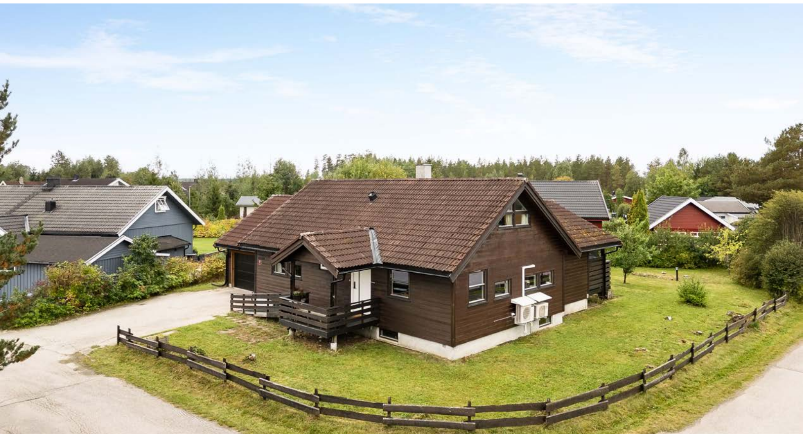
Eiendommen er bebygd med en stor enebolig fra 1985 med inntilbygget garasje.
