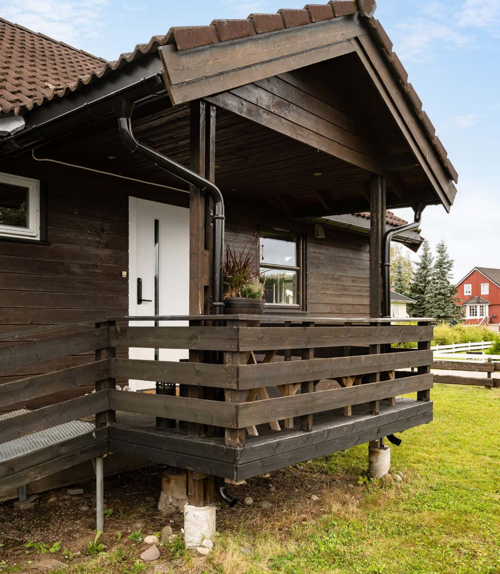
Utvendig rampe opp til inngangspartiet.
