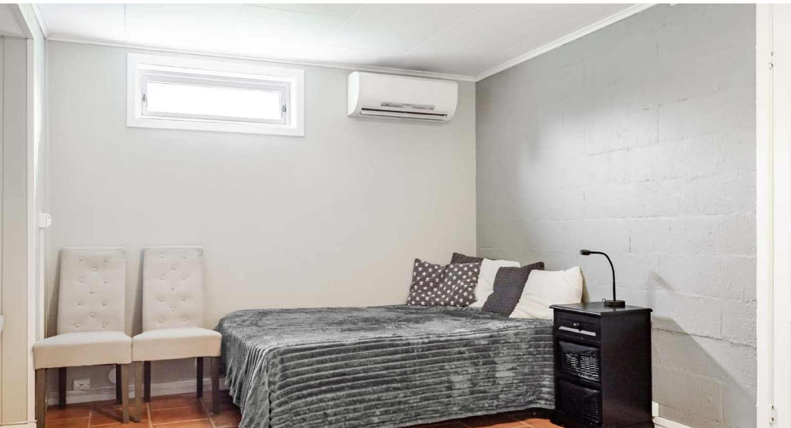
I kjellerstuen er det også montert en luft-til-luft varmepumpe som gir god varme på vinterstid.
