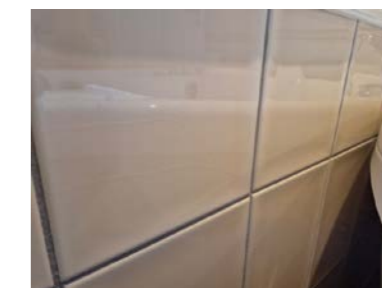
Krakelering av fliser.
