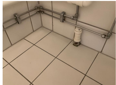
Usikret gjennomføring av eldre jernrør.
