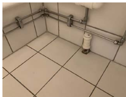
Usikret gjennomføring av eldre jernrør.
