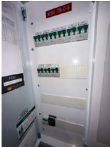
Sikringsskap med automatsikringer.
