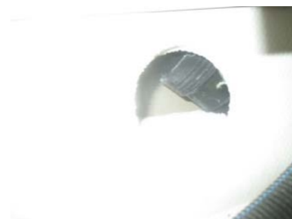
Hulltaking i fra undersiden av kjøkkenbenken.
