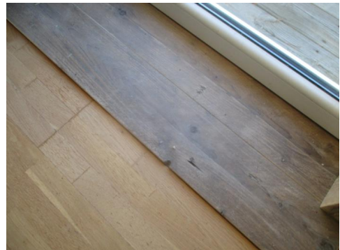
Er blitt lagt et nytt gulv over skadet parkett.
