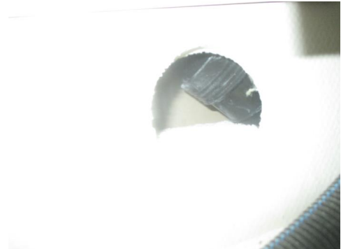
Hulltaking i fra undersiden av kjøkkenbenken.
