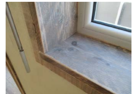
Er blitt lagt på nye foringer i hovedetasjen.
