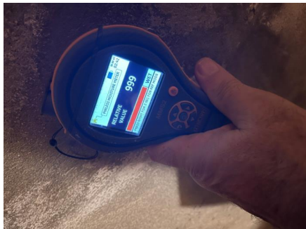
Vegg i bod innenfor terrasse.
