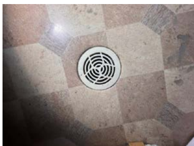
Belegg har ikke oppbrett på vegg og er ikke sveiset i skjøt
