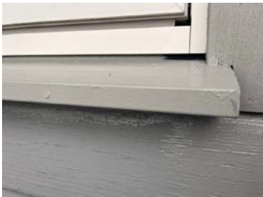
Omramming ned mot vannbrett
