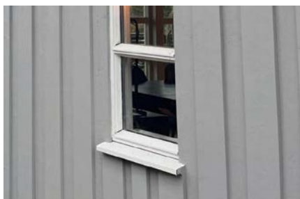
Omramming ned mot vannbrett, noe malingslitt utvendig.
