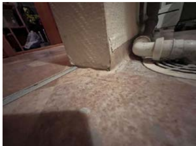
Belegg har ikke oppbrett på vegg og er ikke sveiset i skjøt
