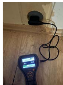
Kontroll i åpning i vegg mot grunnmur.
