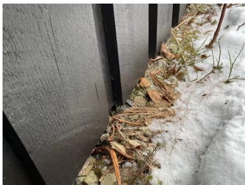
Kledning mot bakken.
