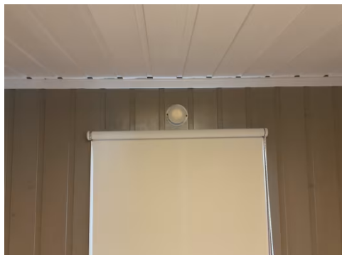
Ventiler i vegg.
