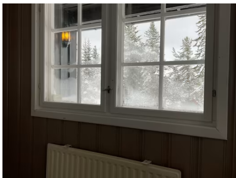
Dugg mellom vinduer.
