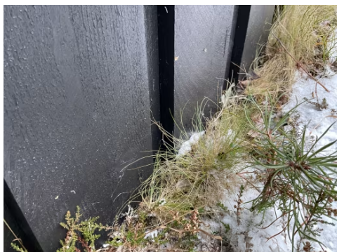
Kledning mot bakken.
