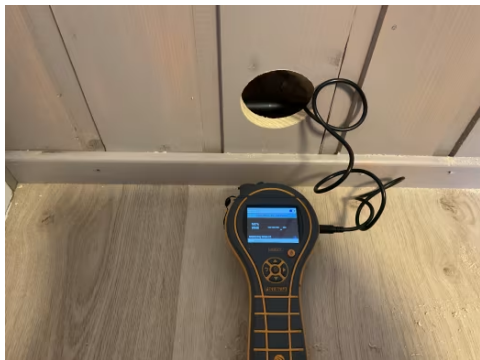
Hulltaking i tilstøtende rom.
