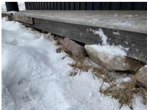
Fundament til terrasse.
