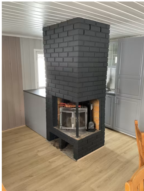
Pipe og ildsted.
