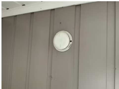
Ventiler i vegg.
