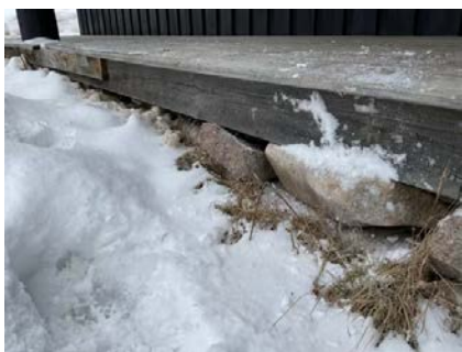
Fundament til terrasse.
