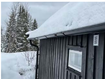
Nedbøy i takrenne.
