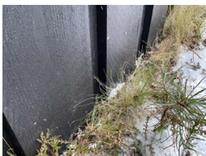
Kledning mot bakken.
