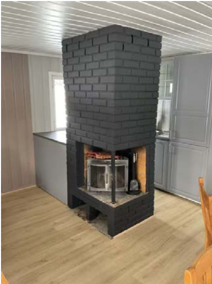
Pipe og ildsted.
