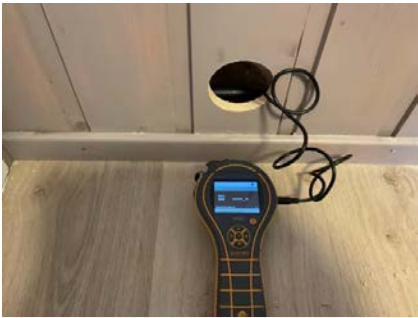
Hulltaking i tilstøtende rom.
