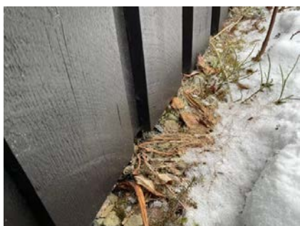
Kledning mot bakken.
