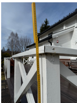
Konstruksjonene har skjevheter.
