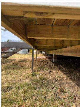
Konstruksjonene har skjevheter.
