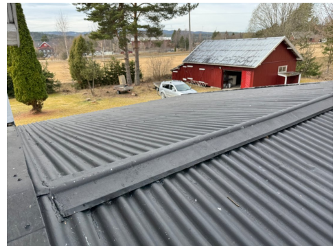
Taktekking av malte bølgeblikplater fra 1962 på tilbygg
