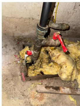
Oppstikk i betongdekke av avløpsrør i støpejern.
