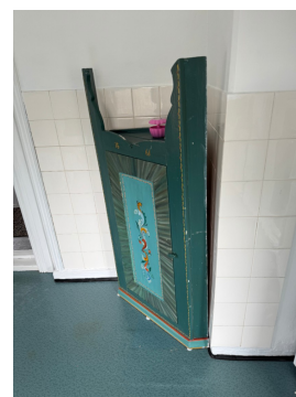
Synlig skjevhet på gulv i 2. etg
