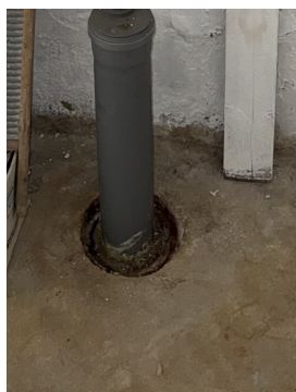
Oppstikk i betongdekke av avløpsrør i støpejern.
