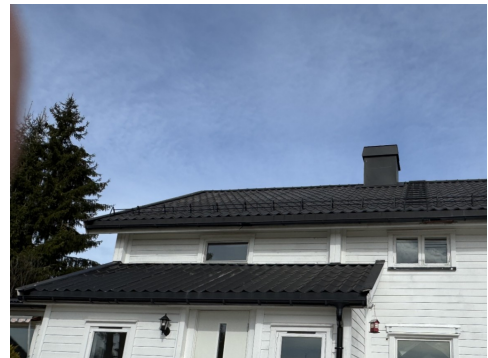
Taktekking av lakkerte takplater med ukjent alder på hoveddel og entré
