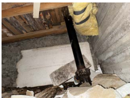
Støpjern avløpsrør
