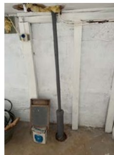
Avløpsrør av plast fra kjøkken til oppstikk av støpejern i betongdekket.
