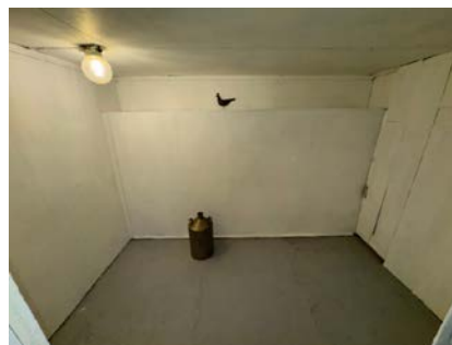
Nymalte og innforede kjellervegger
