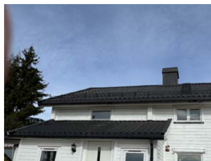
Taktekking av lakkerte takplater med ukjent alder på hoveddel og entré
