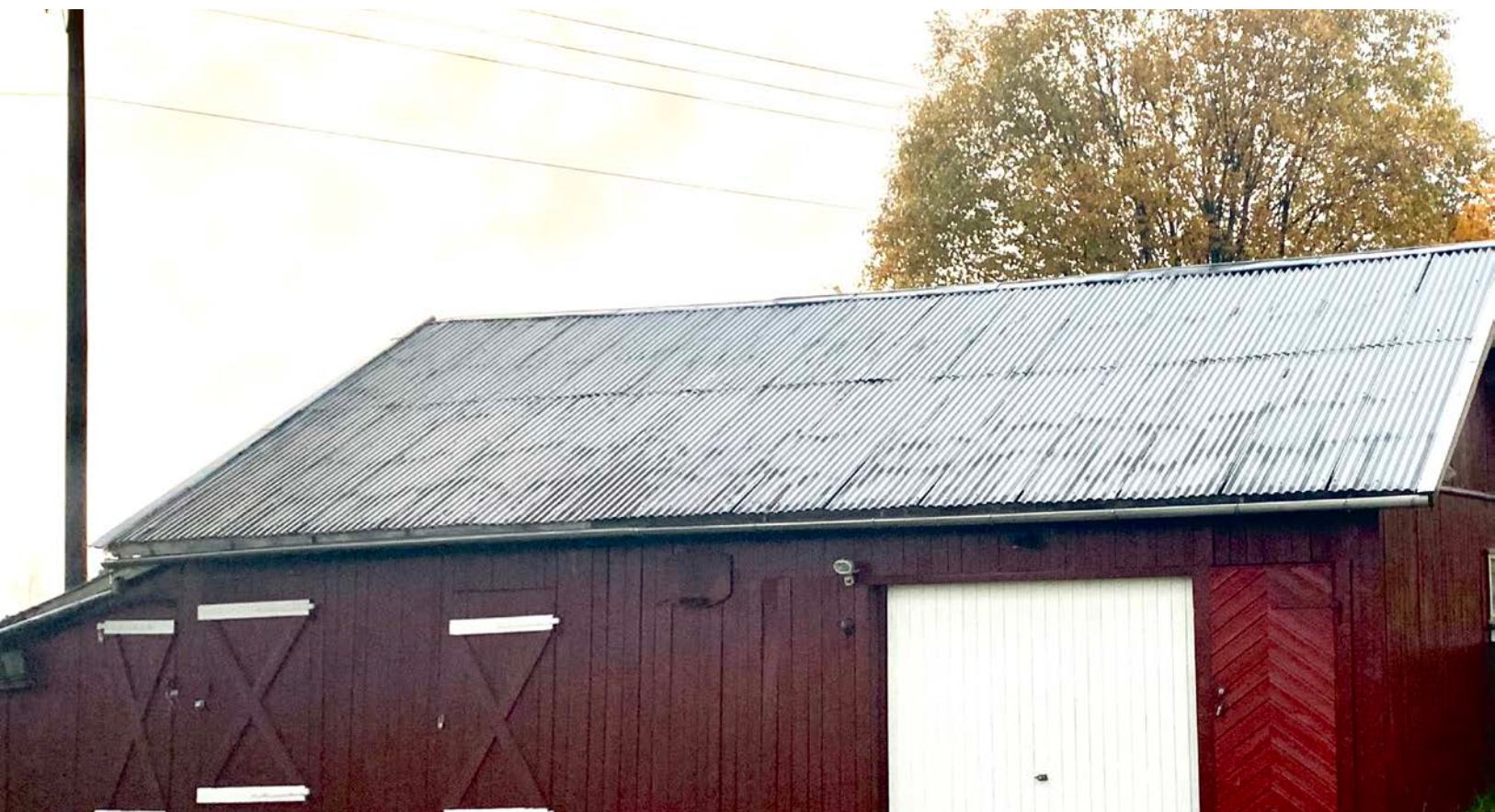
På eiendommen er også et uthus med boder og garasje.
