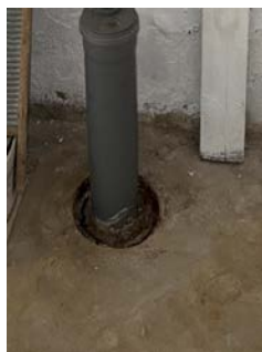
Oppstikk i betongdekke av avløpsrør i støpejern.
