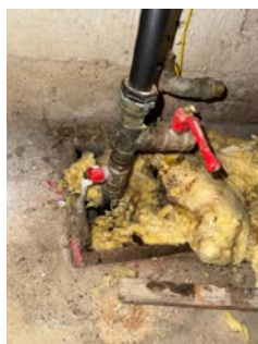
Oppstikk i betongdekke av avløpsrør i støpejern.
