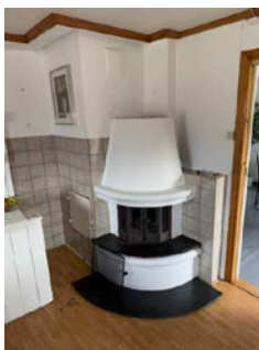
Ca 1/2 part av pipeløp forblendet med fliser på kjøkken.
