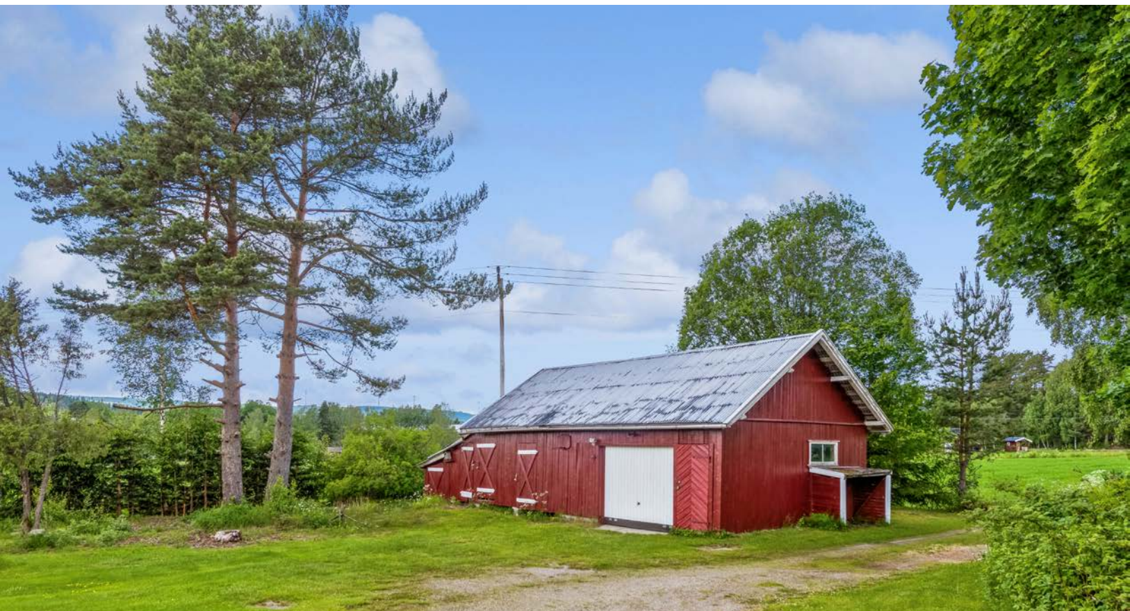
Uthus med boder og garasje.
