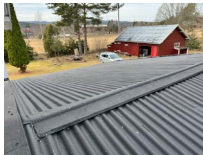
Taktekking av malte bølgeblekkplater fra 1962 på tilbygg
