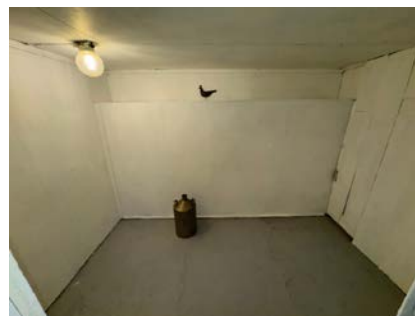
Nymalte og innforede kjellervegger
