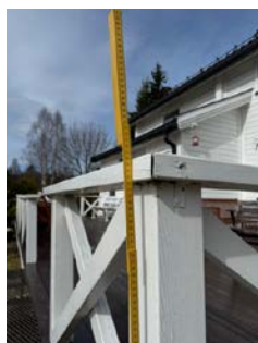
Konstruksjonene har skjevheter.
