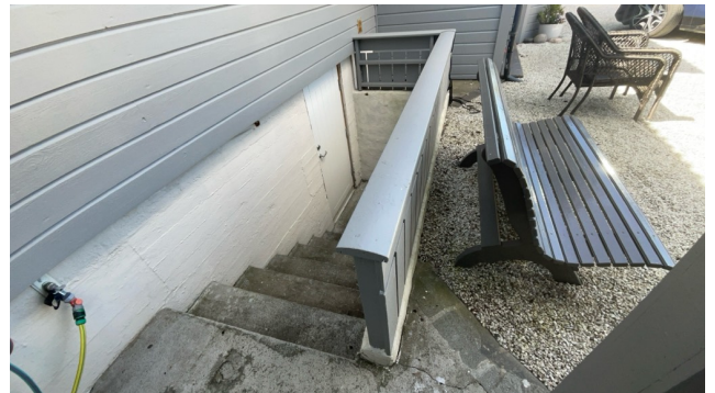
Rekkverk rundt kjellertrapp er for lavt iht. krav i forskrifter.
