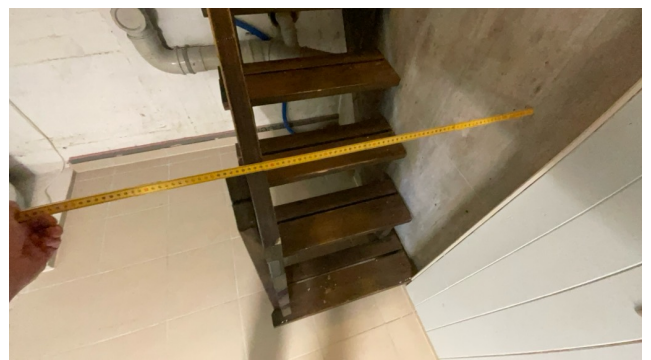
Innvendig trapp er for smal iht. krav til fri bredde i forskrifter.
