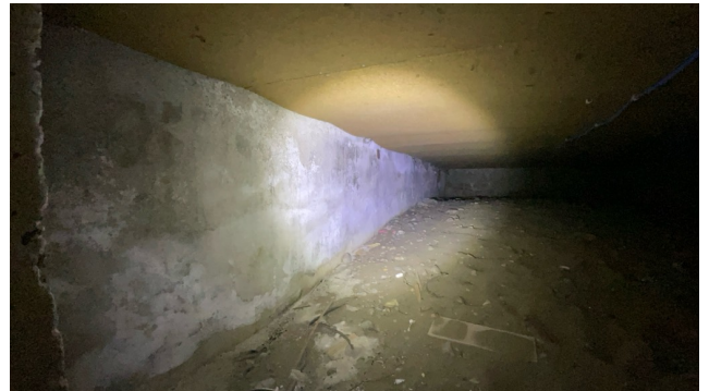
Krypkjeller. Det er ikke synlige ventiler i ringmur.
