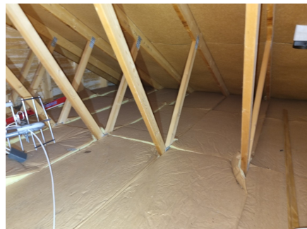
Ingen synlige luftespalter på loft mot raftekasse over isolert lagerrom ved garasje
