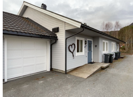
Takrenne med nedløp er ført til avløp i terreng
