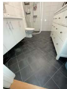
Oversikt gulv hvor hjelpesluk er plassert under servantskap og hovedsluk inne i dusj.
