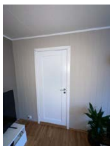
Dør til lagerrom sett fra stue, dør er justert etter befarings
