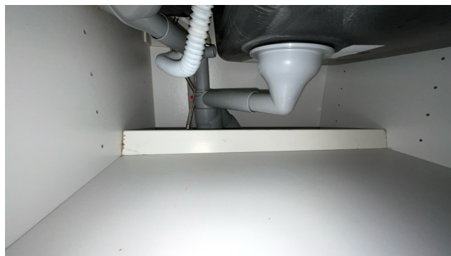
Besiktigelse av røropplegg.
