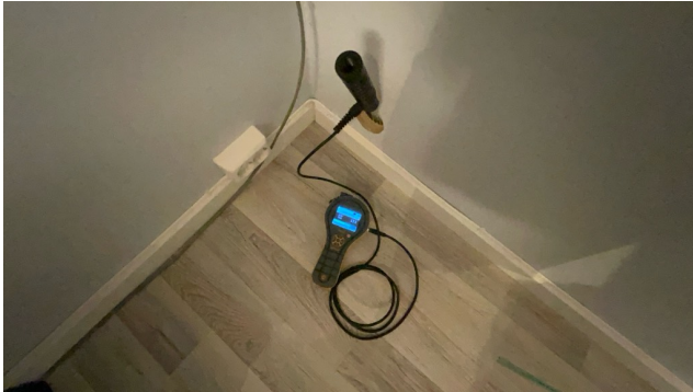
Utført hulltaking på rom under terreng.
