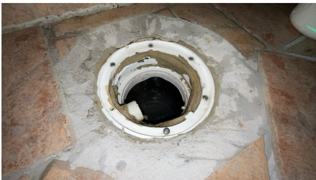
Kontroll av sluk.
