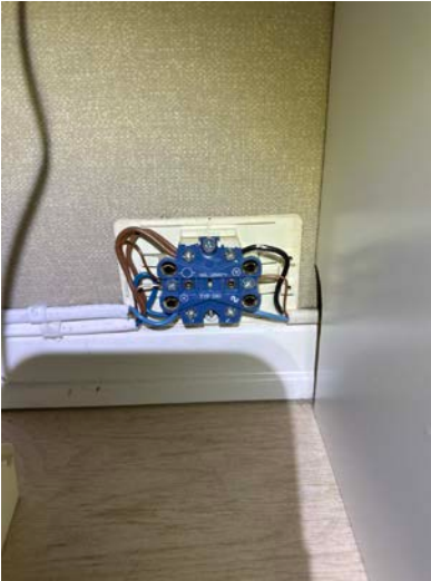
Bilde 5 Stikkontakt i hjørnet til venstre rett ved inngang av stue.
