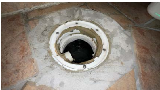
Kontroll av sluk.
