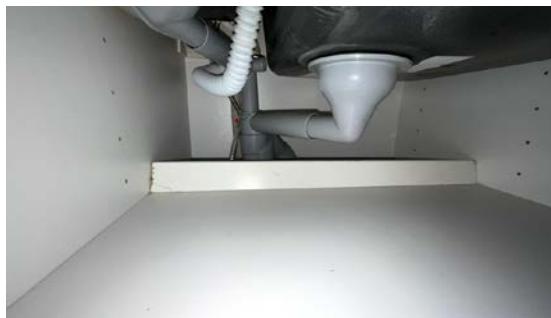
Besiktigelse av røropplegg.
