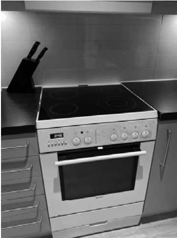
Bilde 1 Anbefaler montasje av komfyrvakt.
