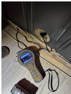
Ikke målt noe unormalt med fukt.
